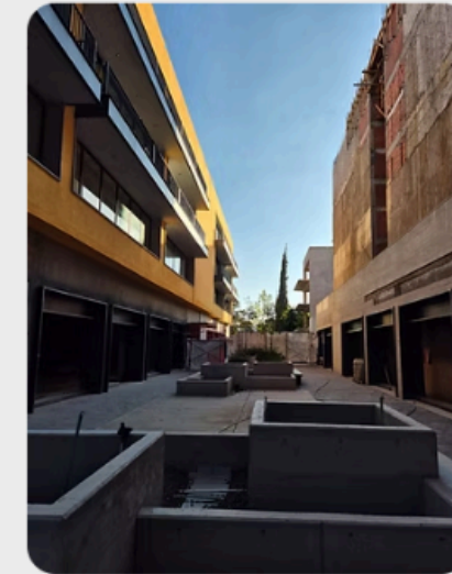
Obra civil Santiago de Querétaro, Querétaro
